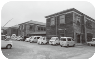
旧明倫小学校3・4号棟
