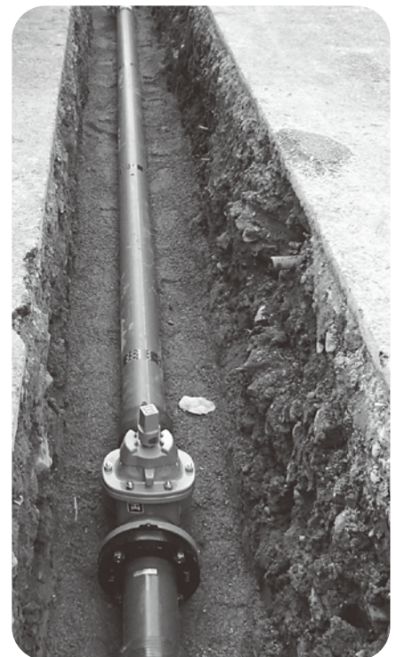
配水管布設替え
