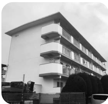
市営住宅 修繕後
