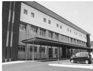
総合福祉センター (令和元年7月完成)
