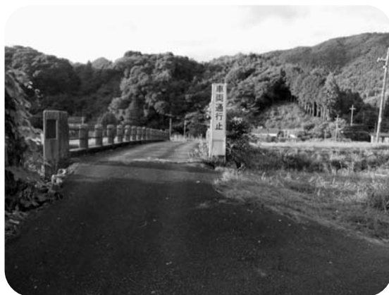
通行止の下小川小島樫久橋
