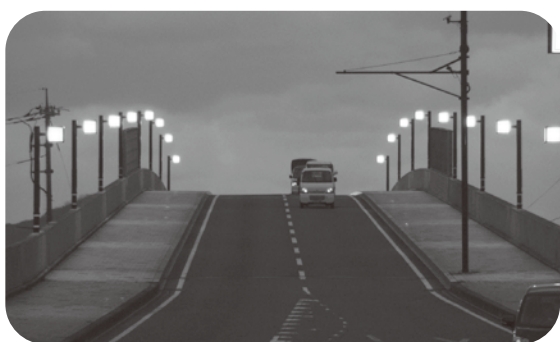
松陰大橋の街灯
