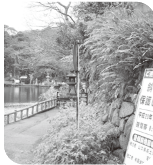
通行止めの周辺道路
