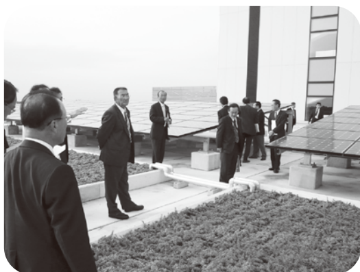
つくば市役所設置太陽光パネル
