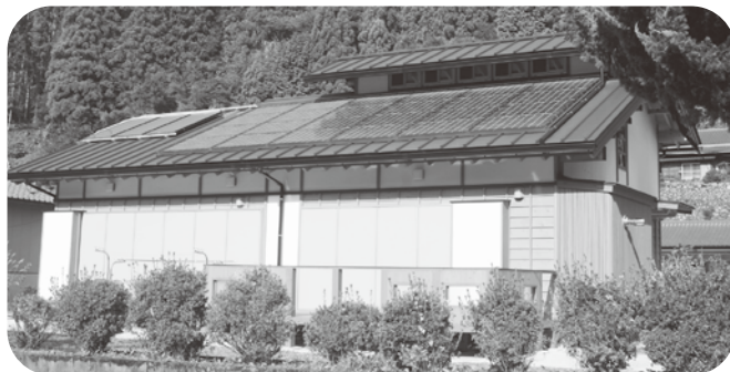
太陽光発電設置民家
