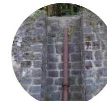
農業近代化の先駆けとなった 揚水ポンプ
