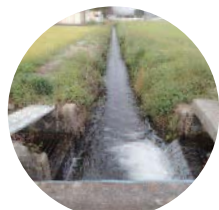
逆サイフォン式による用水路 (先人たちによる農業の工夫)
