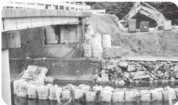
大井門前橋付近の修復工事
