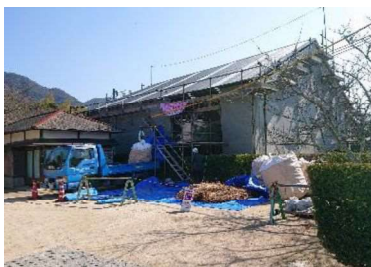
史跡の保存修理 (国指定史跡 伊藤博文旧宅)
