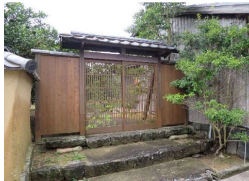
【平安古鍵曲り門扉修繕 完成】
