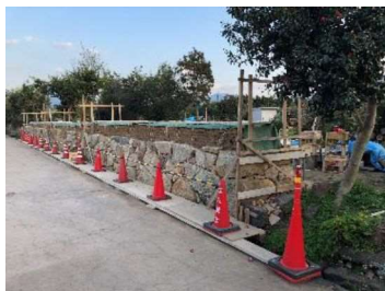
伝統的建造物(土塀)の保存修理 (堀内伝建地区)
