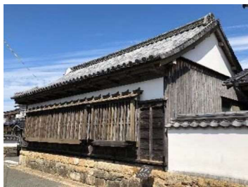
伝統的建造物の保存修理 (堀内伝建地区)
