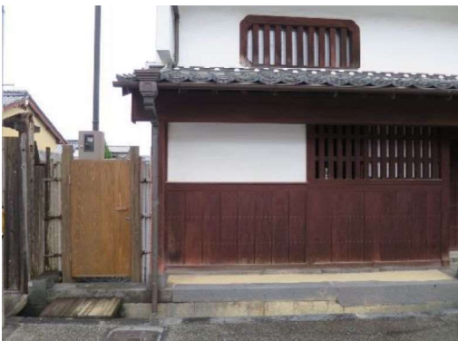
【旧久保田家住宅 西脇門修繕 完成】
