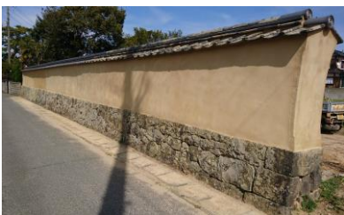
伝統的建造物(土塀)の保存修理 (堀内伝建地区)
