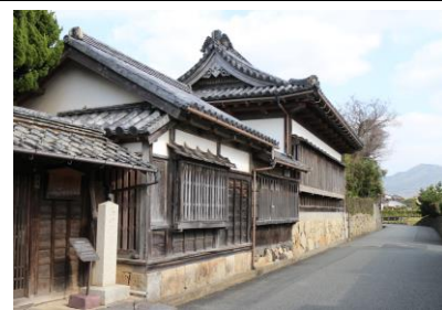
伝統的建造物(物見矢倉)の保存修理 (堀内伝建地区)
