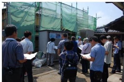
文化財の修理見学会 【富川家住宅(国史跡の構成建造物)】 平成30年6月9日(土)(45人)
