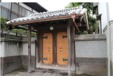
伝統的建造物(門)の保存修理 (浜崎伝建地区)
