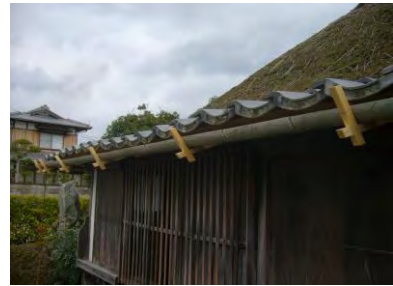
文化財建造物の維持修理 (国指定史跡萩城城下町 伊藤博文旧宅)
