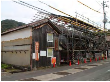
公有伝統的建造物の整備 (佐々並市伝建地区 旧小林家住宅)
