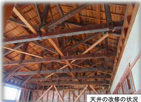
天井の改修の状況
