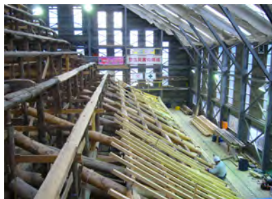
重要文化財の保存修理 (国指定重要文化財大照院)
