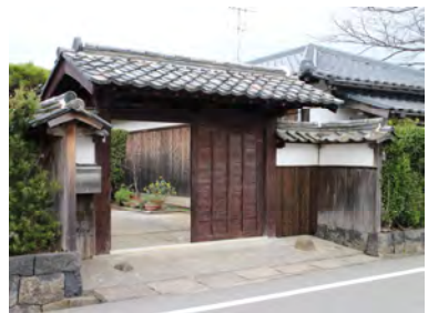
伝統的建造物(屋敷の門)の保存修理 (堀内伝建地区)
