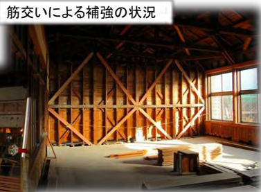
筋交いによる補強の状況
