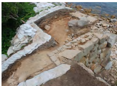
国指定史跡の保存修理 (国指定史跡萩城跡 北矢倉南方土塀跡)
