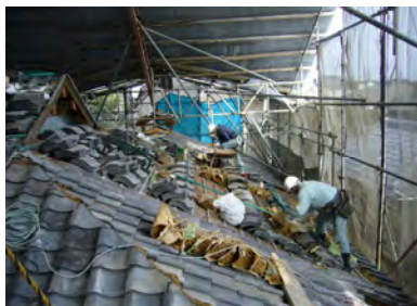
国指定史跡の保存修理 (国指定史跡萩城城下町 青木周彌旧宅)
