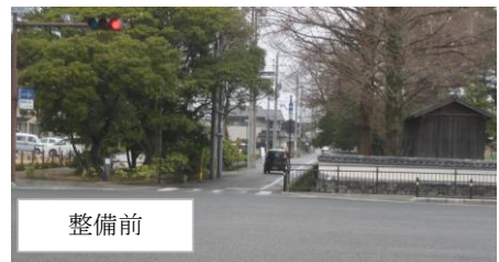
③ 進入路整備
