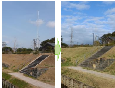
文化財の周辺環境の保全 (香雪園内中継放送所の移設)
