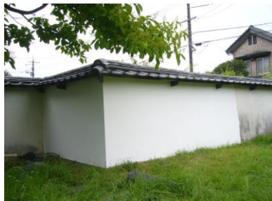
文化財建造物の維持修理 (国指定史跡菟城城下町 林市太郎旧宅)
