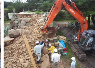
国指定史跡の保存修理 (史跡萩城跡 本丸門跡)
