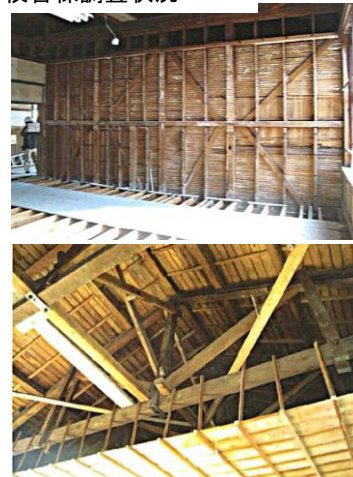
壁・床・天井の一部を剥がし、内部の構造及び老朽度を調査
