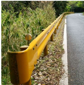
ガードレール
