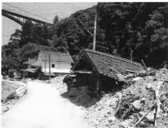
【須佐唐津地区】土砂崩れにより家屋が倒壊、後ろに須佐大橋。被災から2週間目に道路が通行可能に。
