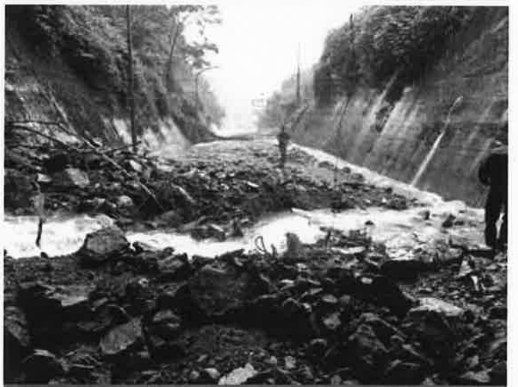
金山谷トンネル (28日)
