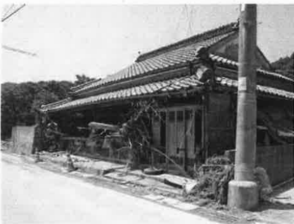
【須佐中津地区】空き家では被災当時のまま、流木などが残っている。
