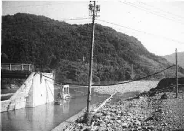
小川樋水管(高岩橋)
