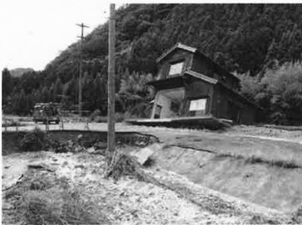
【上小川地区】後ろを流れる原中川の氾濫で地面が削られ、現在も傾いたままの田万川第2分団の消防器庫。
