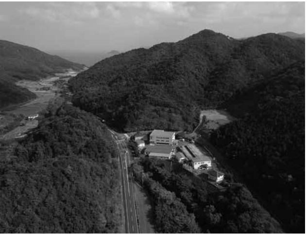
既存の山口工場に隣接して新工場を建設
