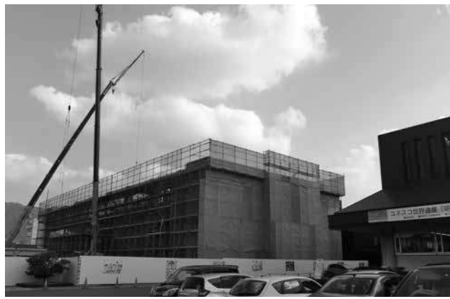
工事中の新総合福祉センター
