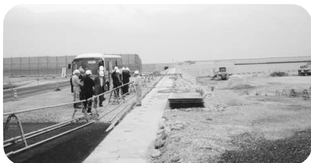
宇部港東見初広域最終処分場
