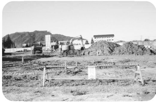
新図書館建設現場
