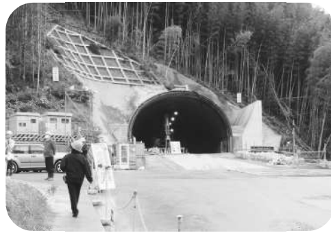
青海第1トンネル
