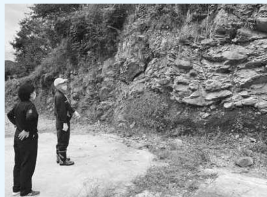
弥富診療センター法面(崖)を視察
