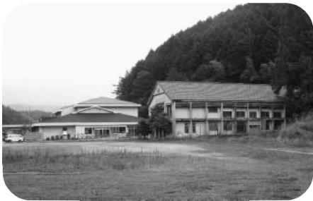
旧高俣小学校体育館
