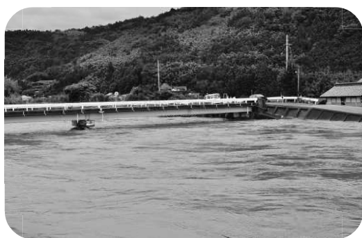
7/21の豪雨 大井市橋周辺
