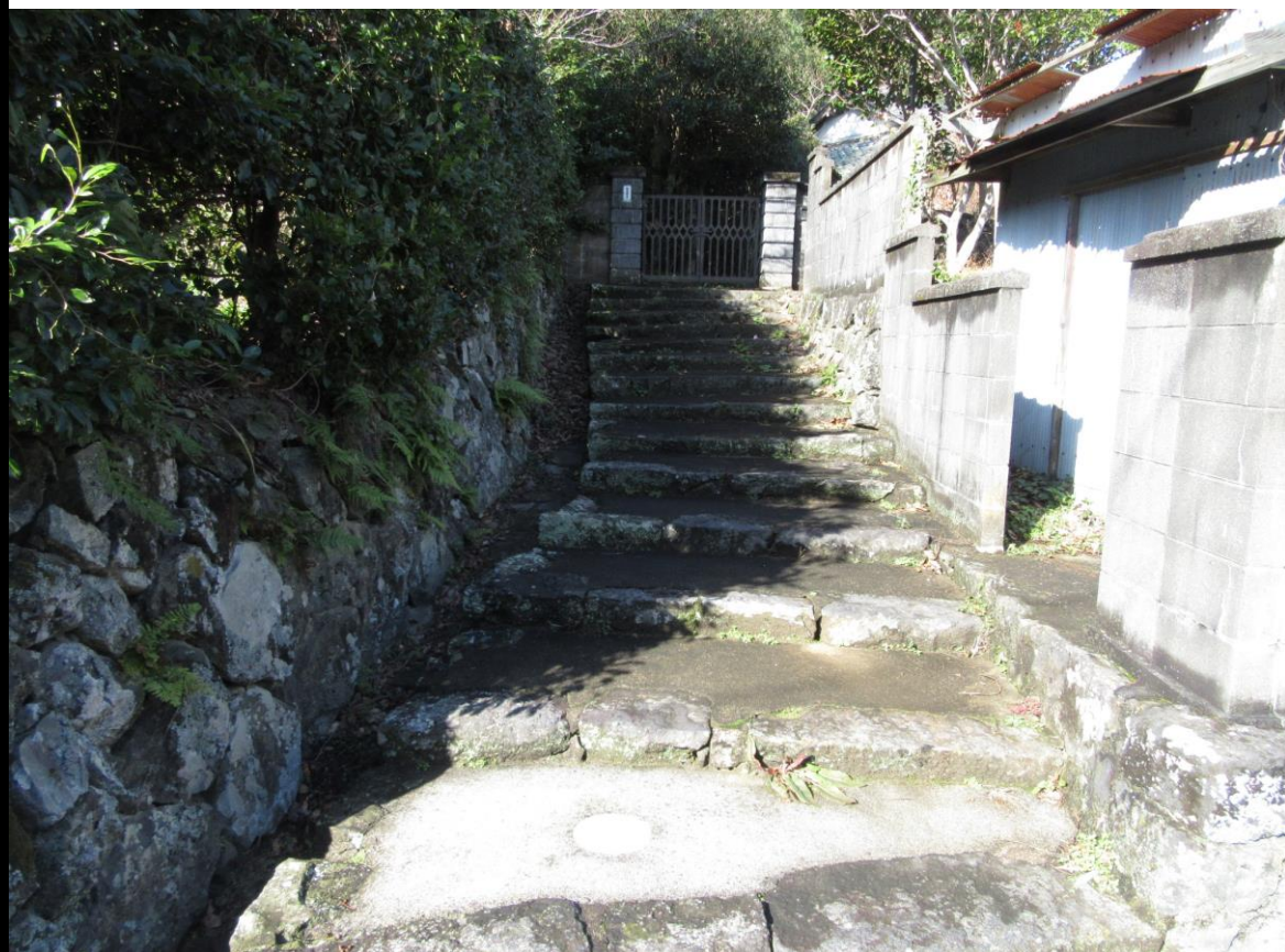
現況写真①
