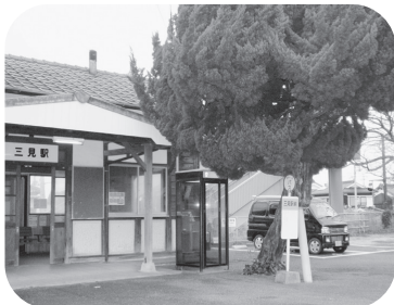
三見駅の撤去されたトイレ跡地
