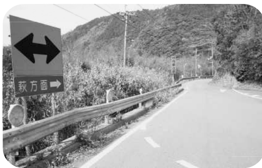
萩川上線 椿瀬合流点付近の拡幅工事の境
