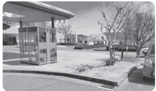
市民病院 駐車場スロープ化予定箇所
