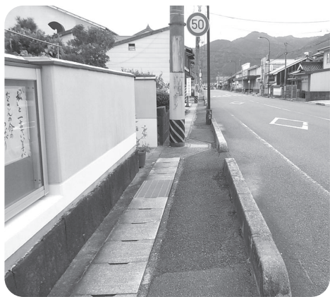
狭あいな歩道内にある電柱
