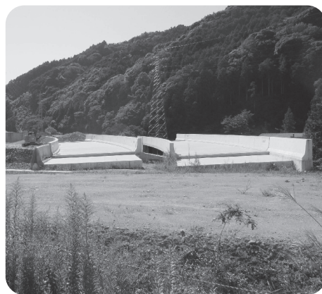
明木IC工事現場
