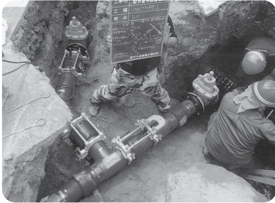
老朽化した配水管の更新工事
