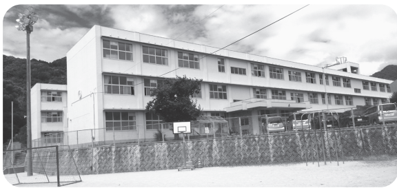
市内の小学校校舎
