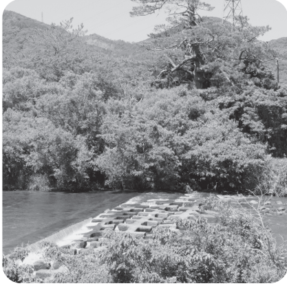
川島地区の繁茂した草木
