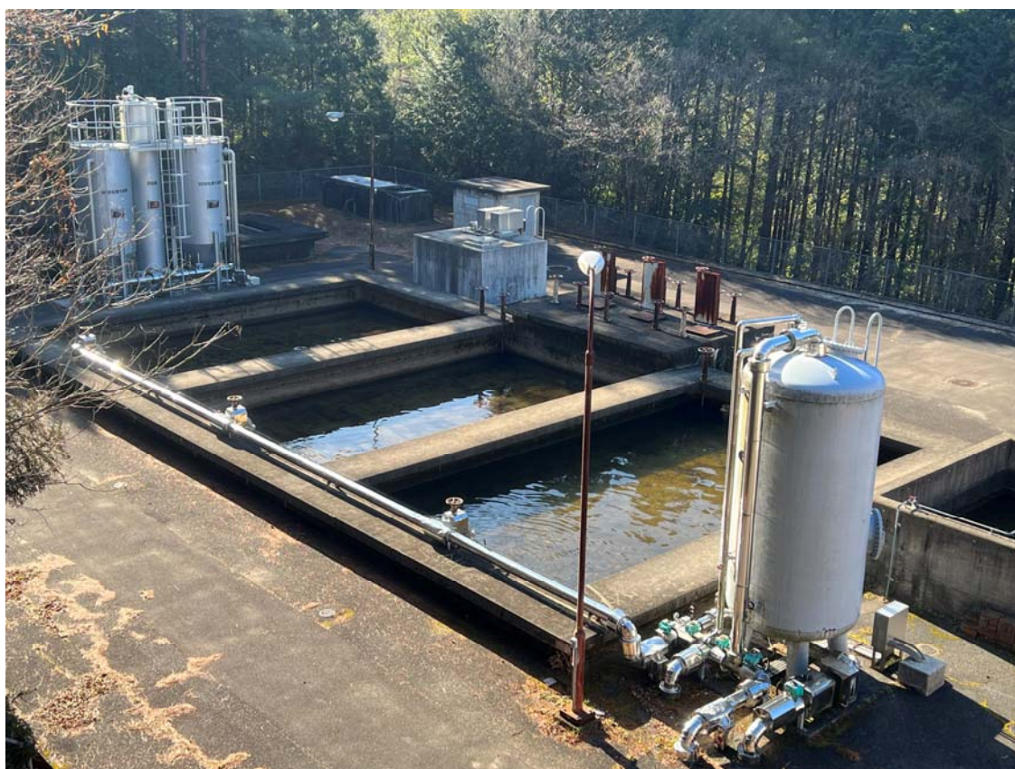
写真：紫福浄水場 緩速ろ過池
