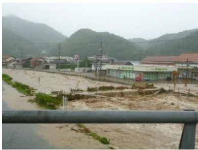
▲弥富地区を流れる田万川も氾濫。橋を超えて流れた濁流により欄干も壊れた。(正午頃)
