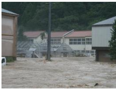
▲小川支所から見た旧小川中学校周辺。原中川と田万川に囲まれた一帯が冠水。(午後1時頃)
