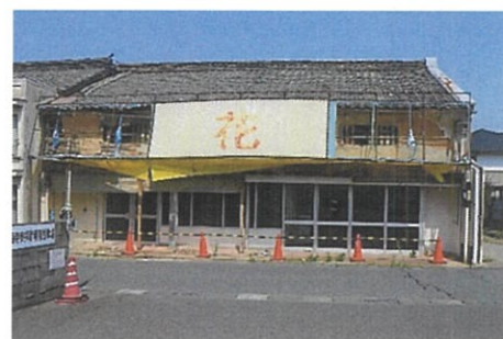
修復整備前の施設（令和2年）
