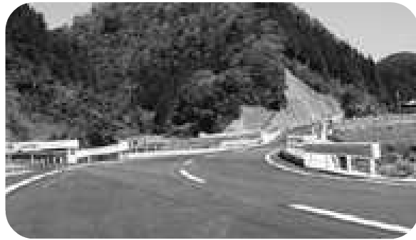
過疎債で整備された市道川上福川線
