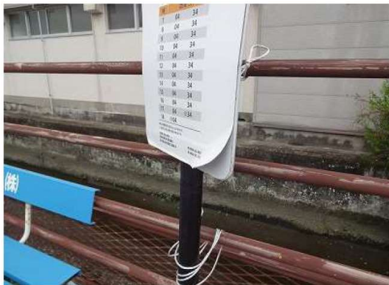
【バス停の劣化状況】
