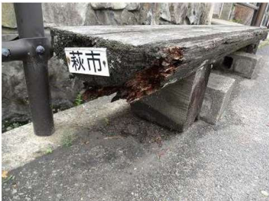
【ベンチの劣化状況】
