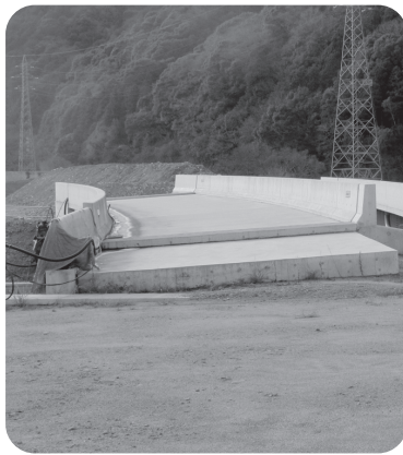
建設中の小郡萩道路
