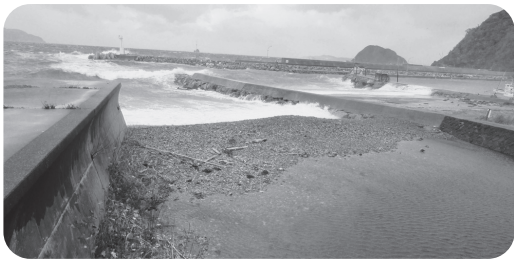
土砂が堆積した三見川河口
