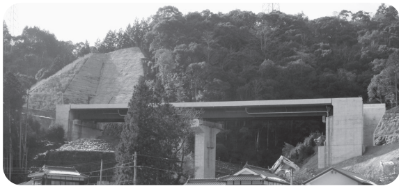
工事中の小郡・萩道路
