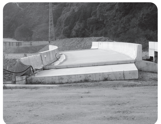
施工中の(仮称)明木インター付近
