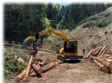
森林団地内の作業の様子
