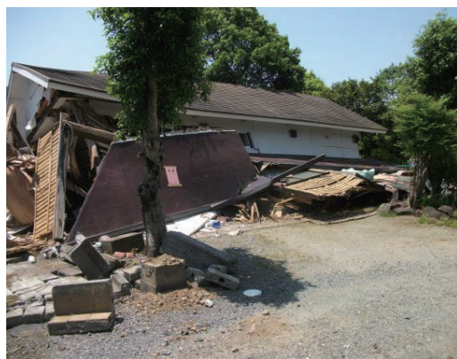
熊本地震で倒壊した木造住宅
