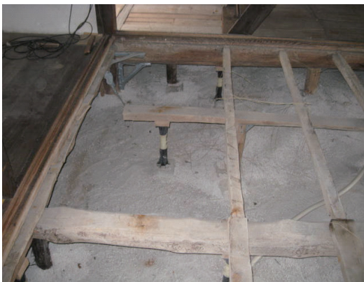
玉石の上に柱が立っている
