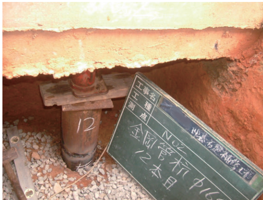
鋼管杭の圧入
