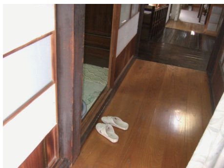
柱脚金物を取り付ける前
