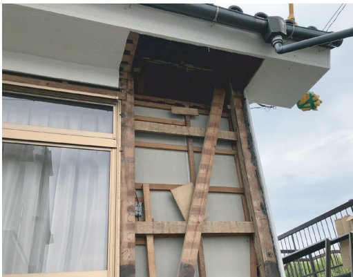
構造用合板等を設置する前
