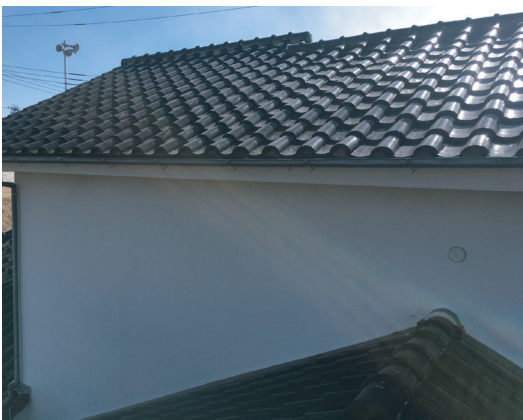
着工前：瓦屋根
