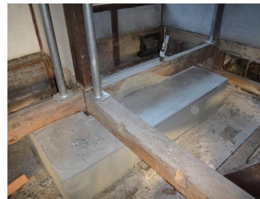
基礎を新たに施工
