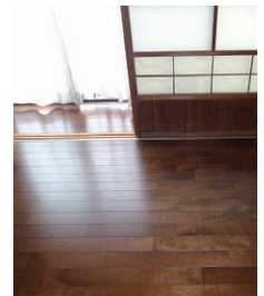
フローリングに改修
