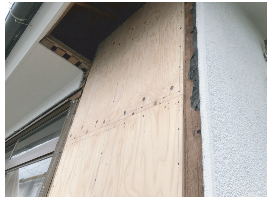
構造用合板等を設置した後
