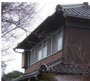
外壁材・アルミサッシ取替え
