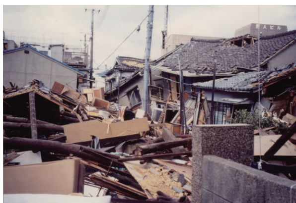
阪神・淡路大震災で被害にあった住宅
