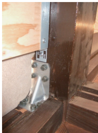
柱脚金物を取り付けた後
