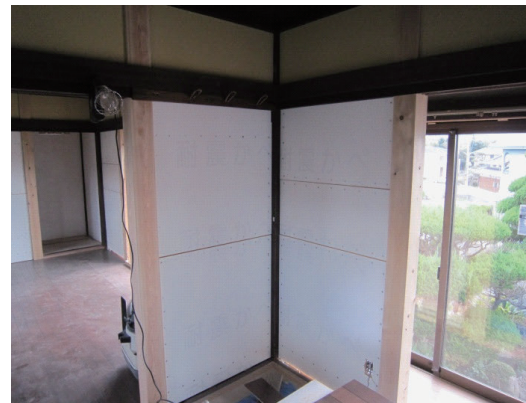
柱と壁を新たに施工
