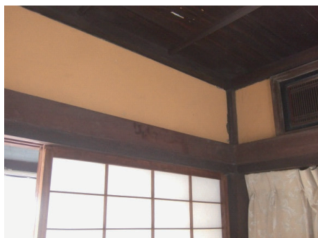
柱頭金物を取り付ける前
