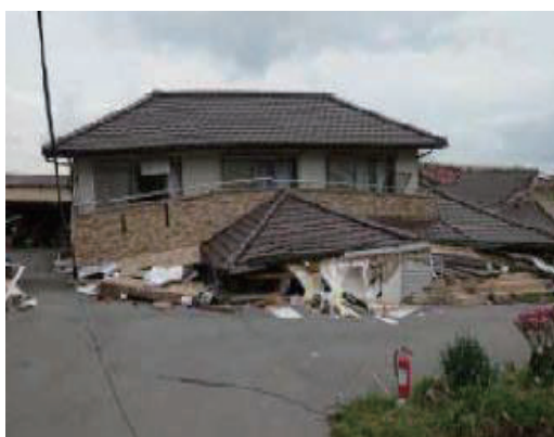
熊本地震で倒壊した木造住宅
