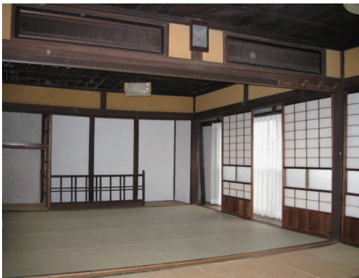
着工前：柱・壁が少ない大空間
