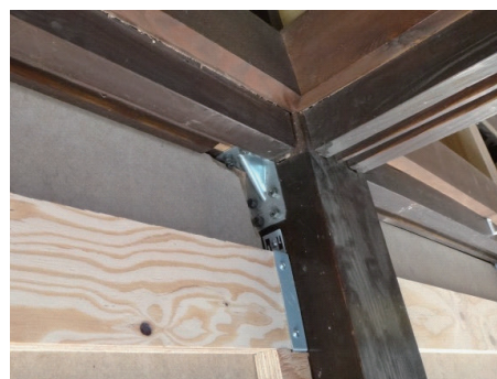
柱頭金物を取り付けた後
