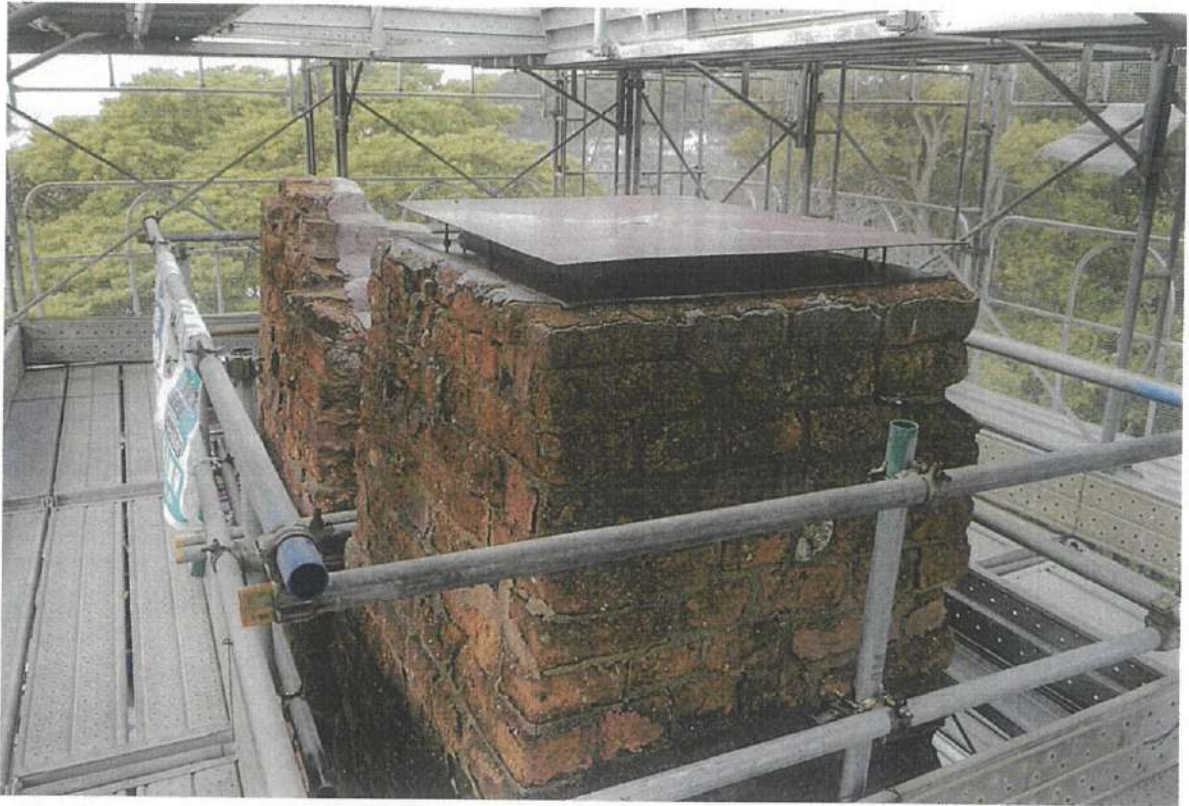
写真3 萩反射炉煙突上部天蓋状況
