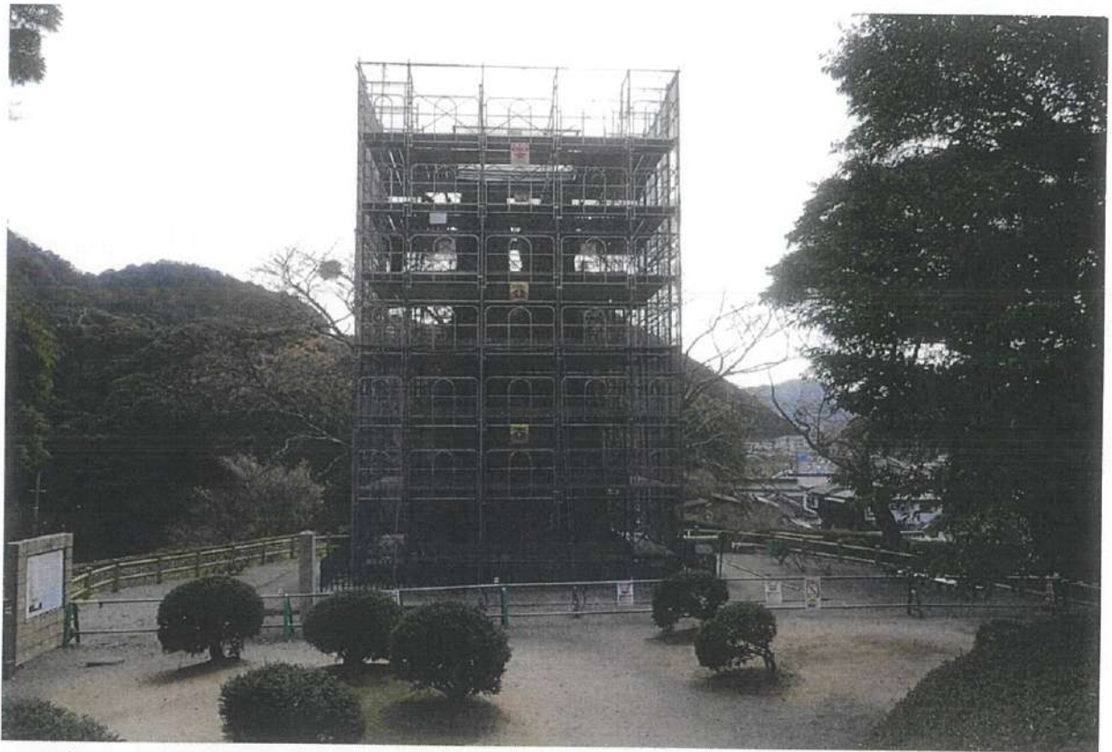
写真1 萩反射炉足場全景
