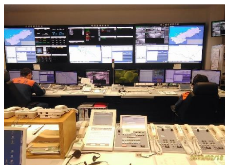
▲萩市消防本部 通信指令室
