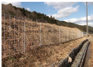
▲侵入防止柵設置
