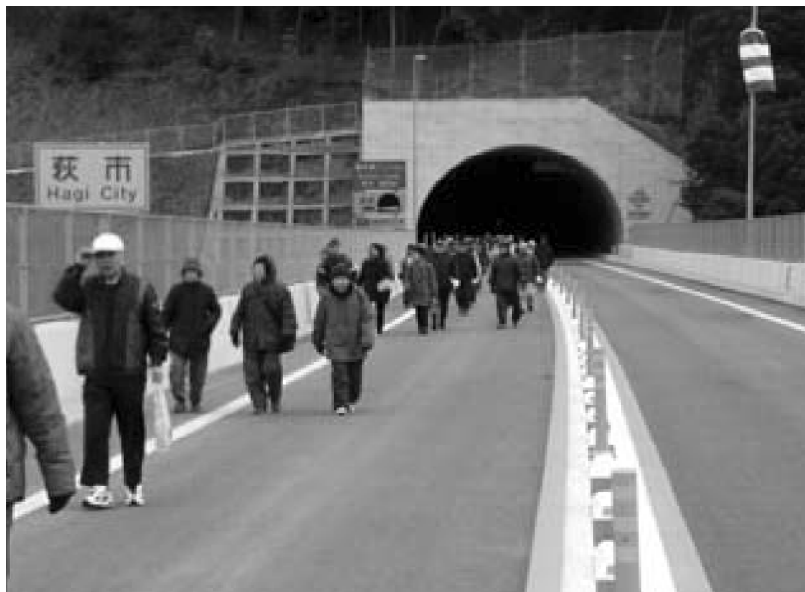
完成した萩・三隅道路
