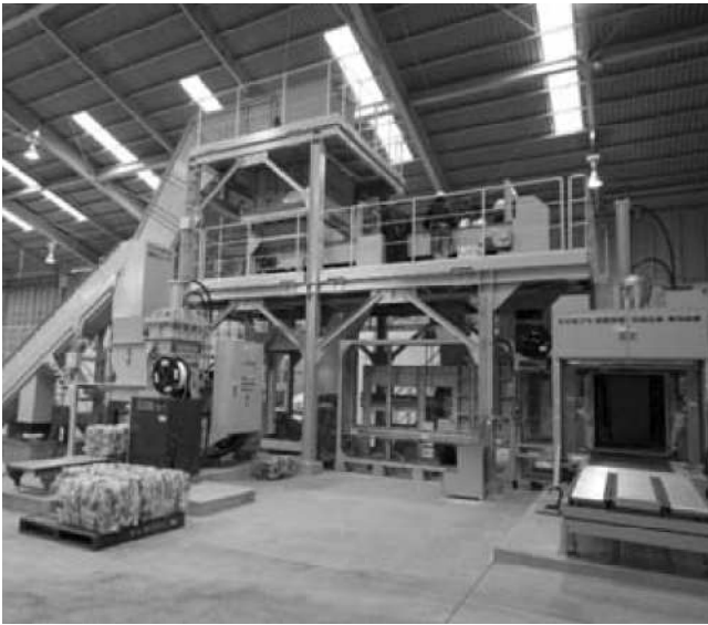
第二リサイクルセンター エコプラザ萩(工場棟)
