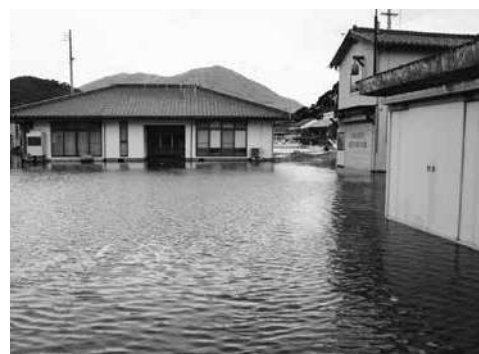
2022年9月6日 台風11号の接近に伴う高潮による浸水被害(江崎地区)
