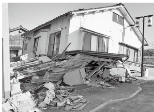
◀倒壊した 家屋
