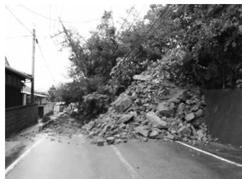
2021年9月15日 大雨による県道11号萩篠生線の土砂崩れ被害(椿東地区)
