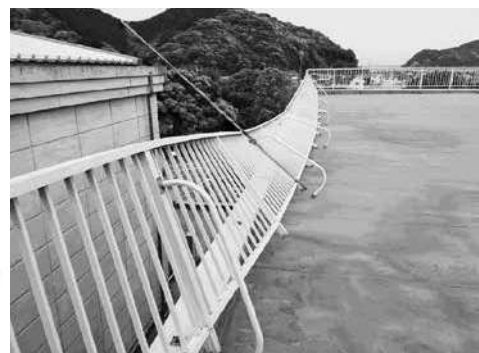
2021年5月10日 強風による手すり倒壊被害(須佐地区)
