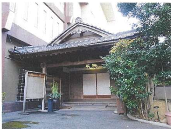
料亭高大玄関及び廊下
