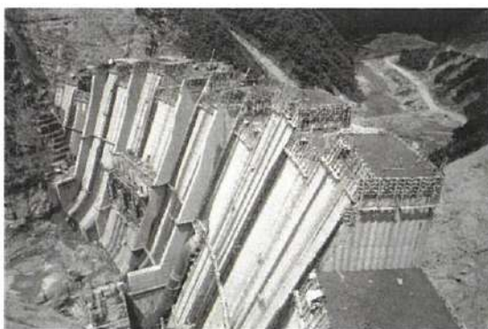
建設中の阿武川ダム
