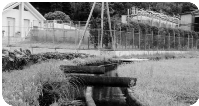
除マンガン装置と排出された水路
