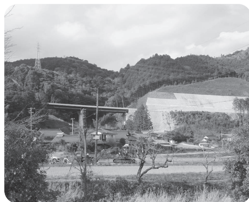
整備中の小郡萩道路
