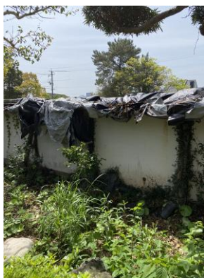
志賀家渡り堀修繕
