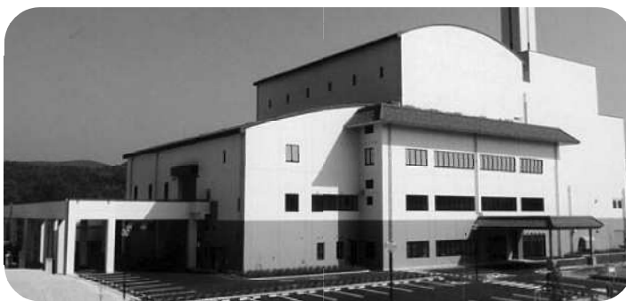
浜田地区広域行政組合 エコクリーンセンター
