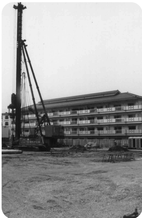
建設中の無田ヶ原口複合福祉施設
