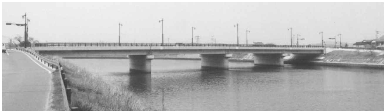
国道262号バイパス橋
