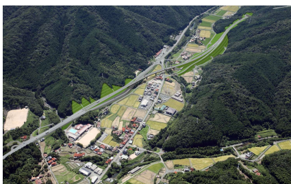
▲地域高規格道路小郡萩道路
