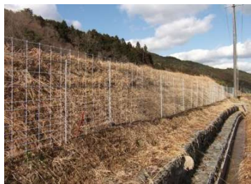
▲侵入防止柵設置
