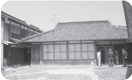
改修される相島定住促進住宅
