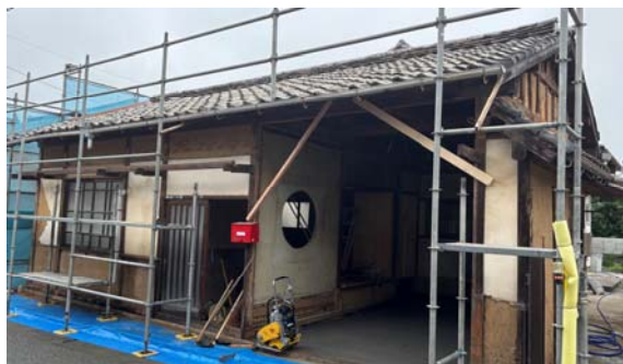
主屋塀修理(浜崎伝建地区)
