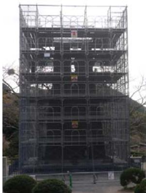
【萩反射炉 足場台の設置】
