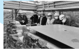
世界遺産構成資産 萩反射炉修理現場 見学ツアー
