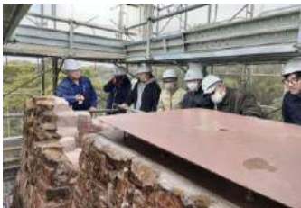
世界遺産構成資産「萩反射炉」 修理現場見学ツアー
